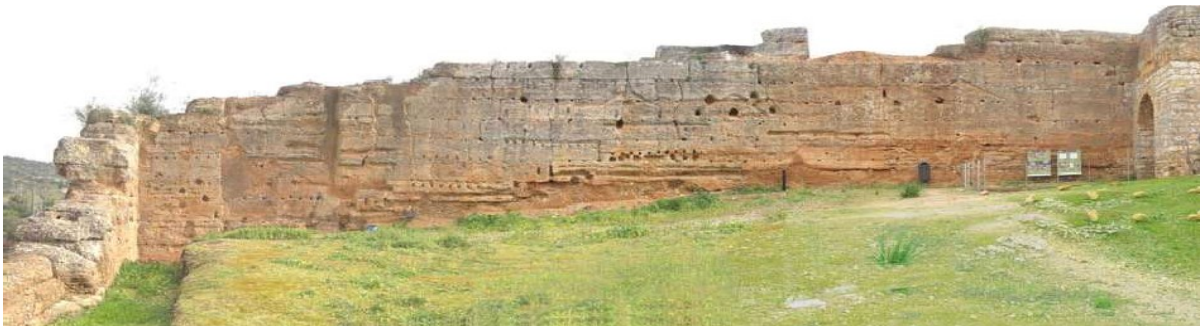
PROJETO DE CONSERVAÇÃO E RESTAURO DOS MÓDULOS DE TAIPA ALMÓADA DO CASTELO DE PADERNE FASE 2 – ALÇADO NE
