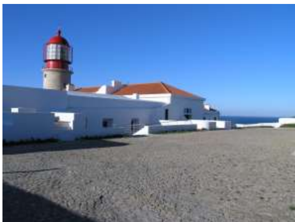
Fig. 4- Antigo Convento de São Vicente (vista das antigas dependências conventuais e igreja). Foto da autora (2005)
